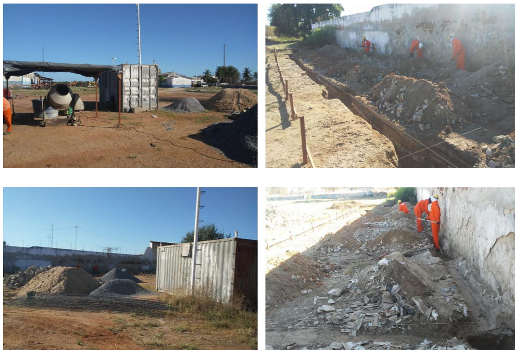
Figura 8. Obras para construção da Área de Transbordo Temporário da Gerência do Terminal Salineiro de Areia Branca.
